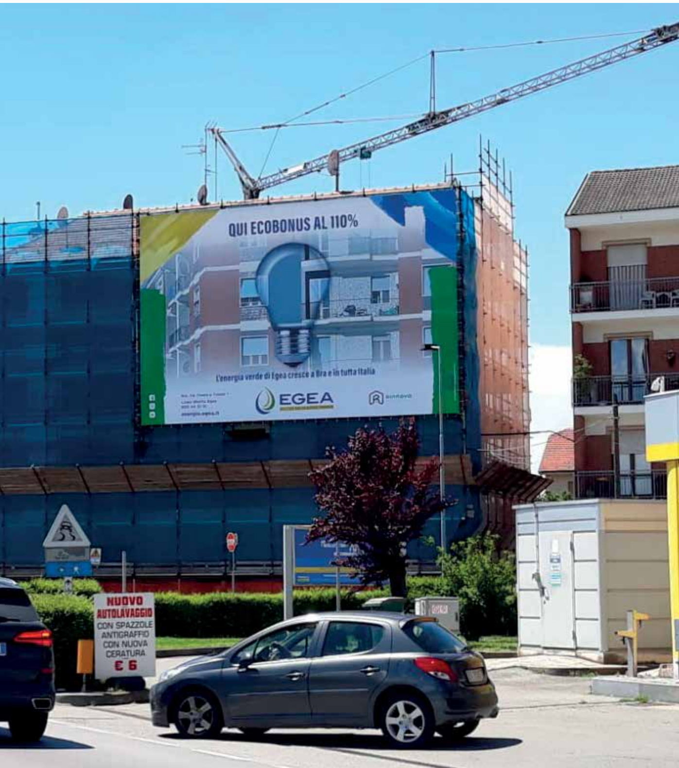
Affissione gigante dell'opera di efficientamento energetico e del Superbonus 110% nel condominio di Via Fratelli Rosselli a Bra
