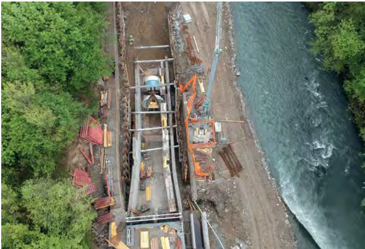
Cantiere per la costruzione della centrale idroelettrica di Alpignano (TO)
