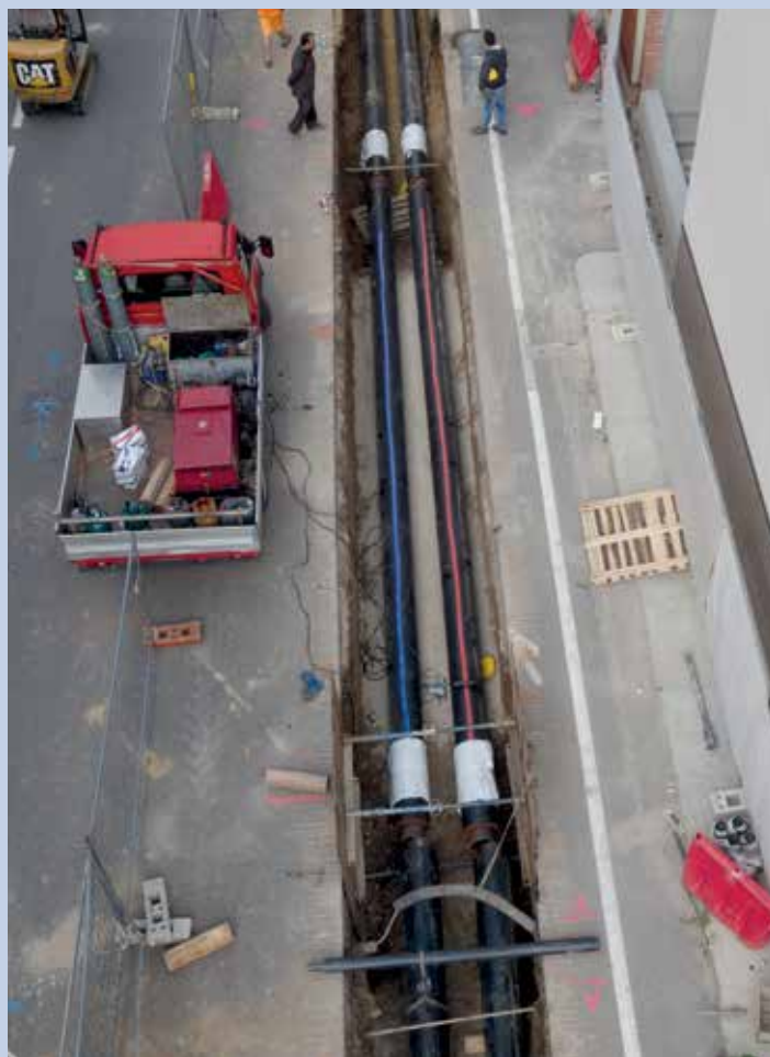
I lavori per la realizzazione del teleriscaldamento di Bra
