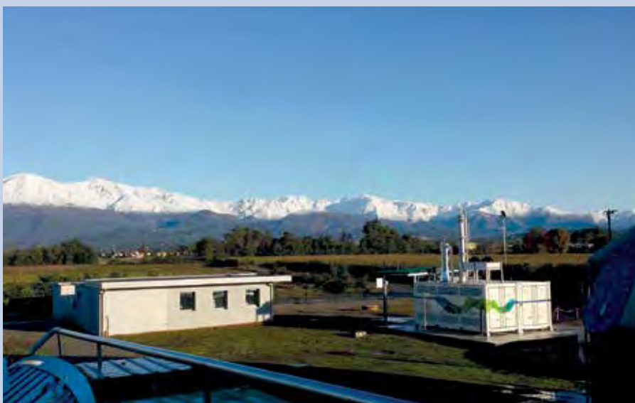
Impianto Biogas di Ozegna (TO)
