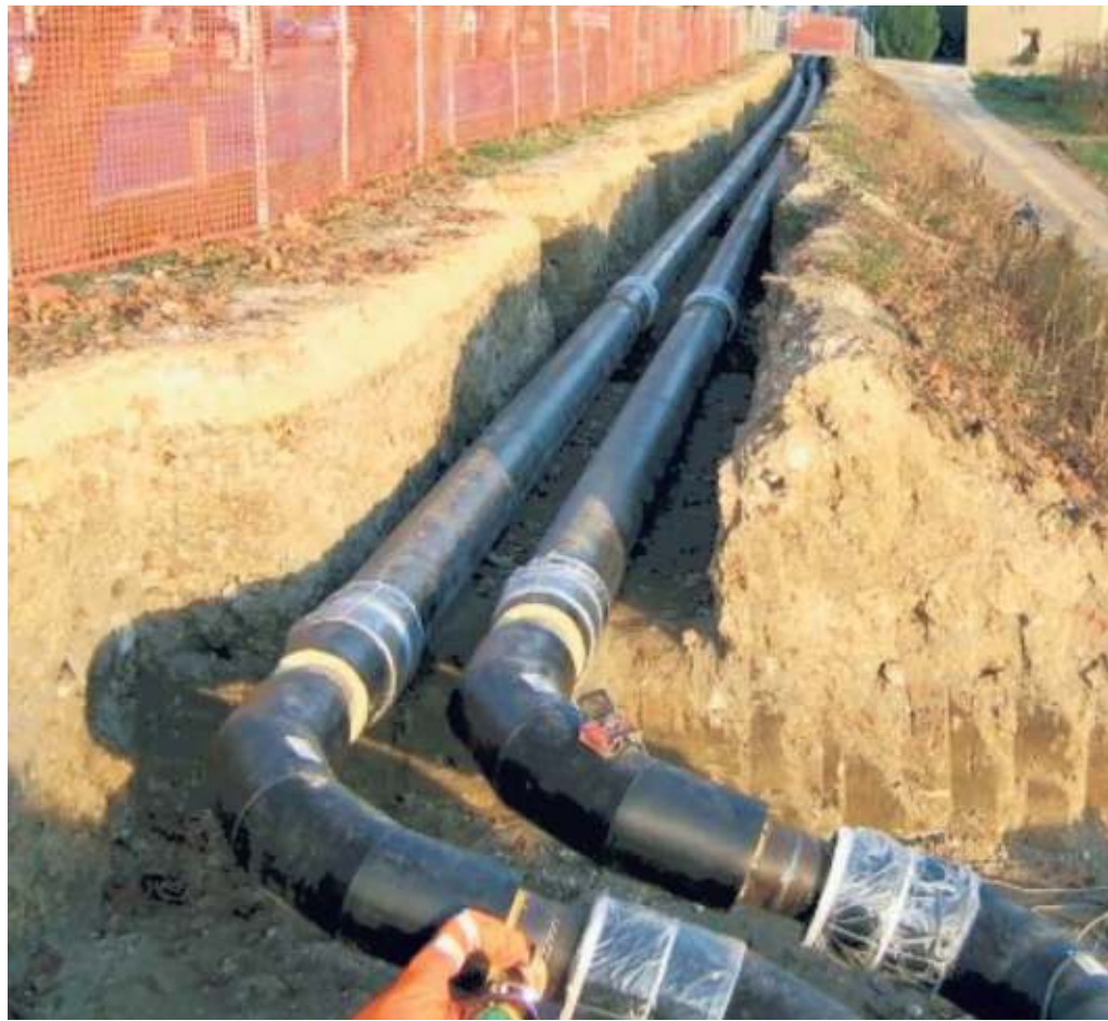
Il piano per le condutture del teleriscaldamento riparte ad Alessandria dopo la frenata per la pandemia
